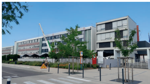
Une photo du chantier de rénovation thermique du lycée Henri MECK à Molsheim: à gauche, le bâtiment tel qu'il était à l'origine; à droite, le bâtiment rénové, avec isolation extérieure, réduction du nombre de fenêtres et remplacement de celles-ci.
